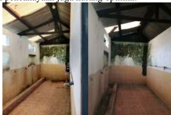
Gambar 4. Kondisi Tempat Wudhu
