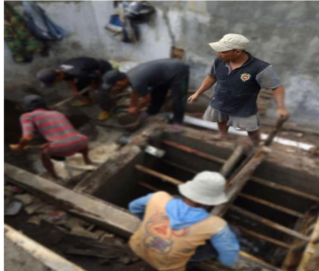
Gambar 2. Pembangunan MCK RW 7
