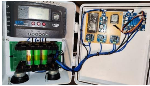
Gambar 5: Isi Box Panel Purwarupa H. Pemasangan Panel Surya dan Box Panel Pada Tripod Penyanngga
