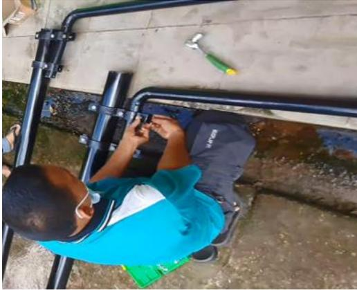
**Gambar 7. Pemasangan klem lengan pada tiang galvanis**
