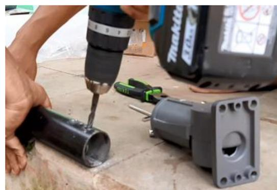
**Gambar 6. Pembuatan lubang pada lengan tiang galvanis**
