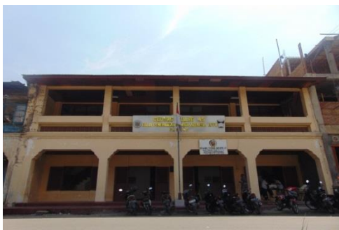
Gambar 4. Gedung Balai Penerangan Pemuda Indonesia (BPPI) yang menjadi saksi bisu awal kemerdekaan Indonesia di Sumatra Barat. (Sumber: https://kebudayaan.kemdikbud.go.id/bpcbsumbar/retakpanjanggedungjoangbppi45padang/ )
